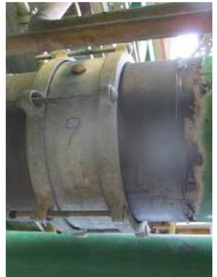
Acoplamiento reparado instalado
