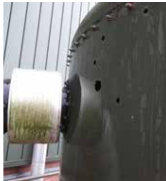
Perforación en la pared
