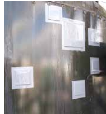
Soldadura de placas en frío
