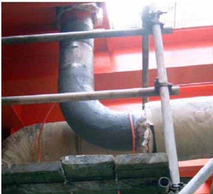
Belzona 1251 (HA-Metal) es un sistema de un solo componente para la reparación y protección de superficies metálicas que se aplica mientras los equipos están en servicio.
