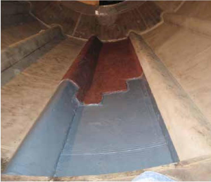
Belzona 1811 (Ceramic Carbide) es un recubrimiento de dos componentes para reparación y protección de superficies expuestas al ataque abrasivo.
