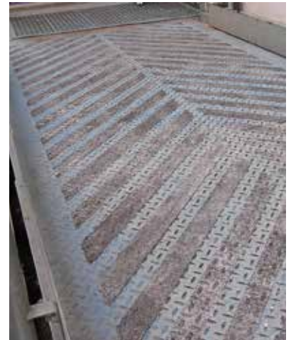
Rampa con franjas de Belzona 1821
