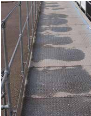
Rampa de acero pulida antes del recubrimiento
