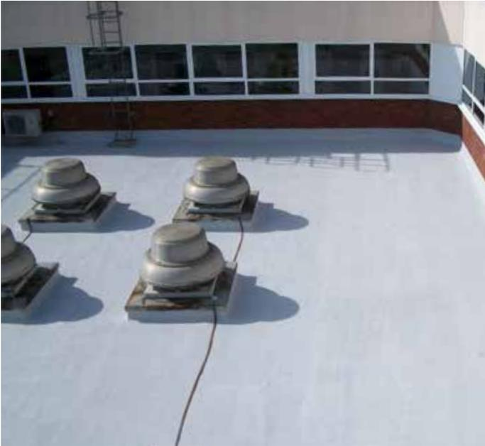
Belzona 3111 (Flexible Membrane) es un recubrimiento microporoso de un solo componente y sin solventes diseñado para reparaciones y protección duradera de todo tipo de techos, bases de tanques y otras estructuras.
