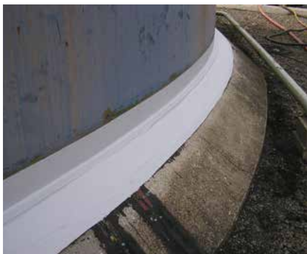
Sellado de base de tanque
