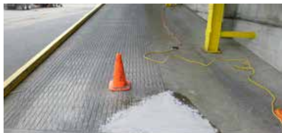
Se empleó el sistema Belzona 4151 + 4111 para reconstruir y alisar el área agrietada.
