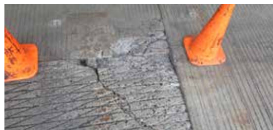
Un panel de hormigón presentaba agrietamiento y causaba problemas en el camino.
