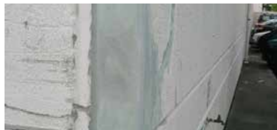
Primero se inyectó Belzona 4151 y luego se rellenaron las grietas con Belzona 4111.
