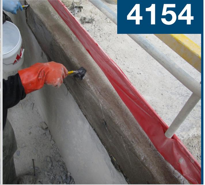
Sistema de reparación de resina a base de epoxi multiusos diseñado para mezclarse con agregados, tales como arena, cuarzo o piedra triturada, y además, es adecuado para las reparaciones realizadas en superficies horizontales como material de nivelación para llenar grandes superficies irregulares, agujeros profundos y grietas. Se adhiere fuertemente a ladrillo, hormigón, piedra natural y otras superficies.
