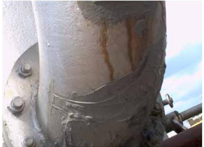
Belzona 4301 utilizado para unir placas a tuberías afectadas por ataque químico
