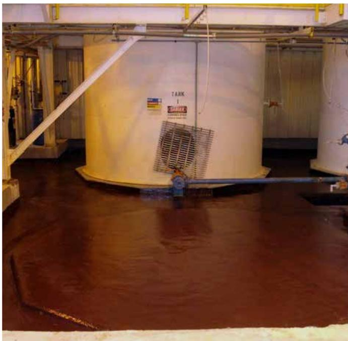
Belzona 4311 (Magma CR1) es un recubrimiento de barrera de dos componentes que puede aplicarse manualmente o con pulverizador para protección de superficies contra el ataque químico.
