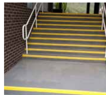
Escaleras de hormigón después de la aplicación
