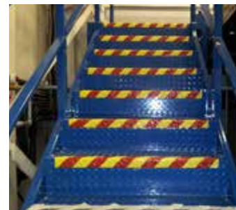
Escaleras de metal después de la aplicación
