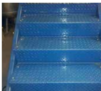
Escaleras de metal antes de la aplicación
