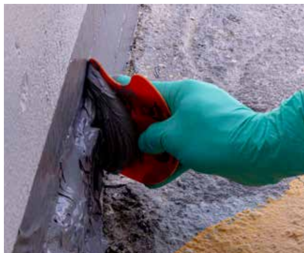
Empleado para reacondicionar juntas defectuosas en área de contención
