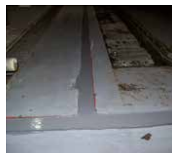
Reparada con Belzona 4521
