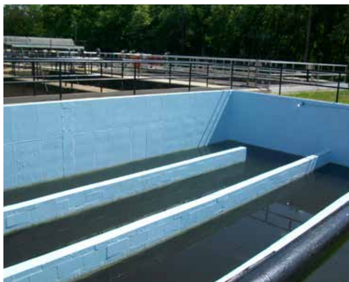
Belzona 5111 empleado para proteger la pared de un tanque de cloro
