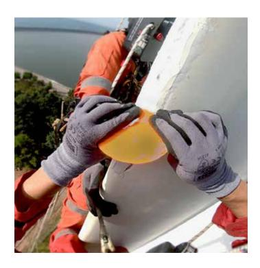
Belzona 5711 es un sistema de alto rendimiento y fácil de aplicar especialmente diseñado para la reparación de daños por erosión e impacto en los bordes delanteros de las palas de las turbinas eólicas
