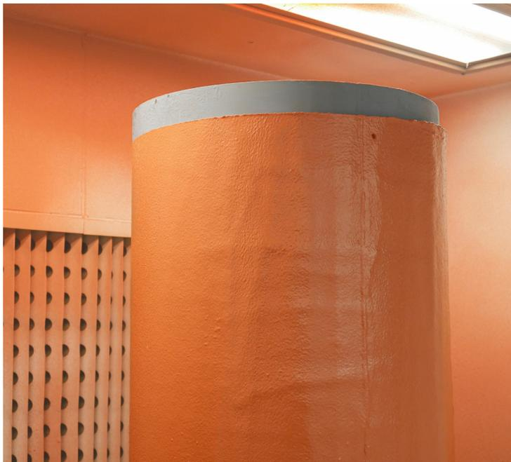
Belzona 5871 es un novedoso sistema polimérico de dos componentes y libre de solventes que proporciona una barrera de aislamiento térmico con protección contra la corrosión y que posee propiedades “frías al tacto” térmicas y bajo cero.
