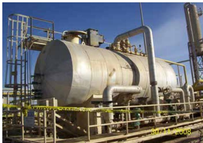
Belzona 5892 empleado para revestir un desalinizador
