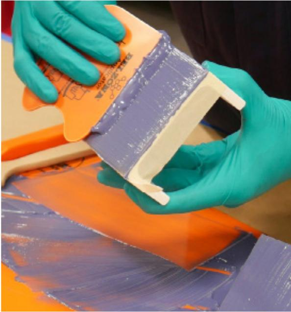
Belzona 7311 es un adhesivo resistente a la fatiga, optimizado para aplicaciones en uniones estructurales que requieren alta resistencia mecánica, así como resistencia a la escisión y al corte. Es un producto ideal para aplicaciones en uniones sometidas a carga cíclica y repetida.
